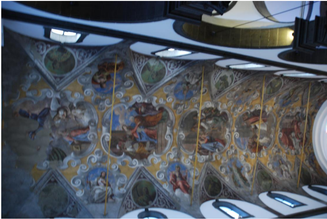
Copertura a padiglione della navata centrale affrescata nel '500
