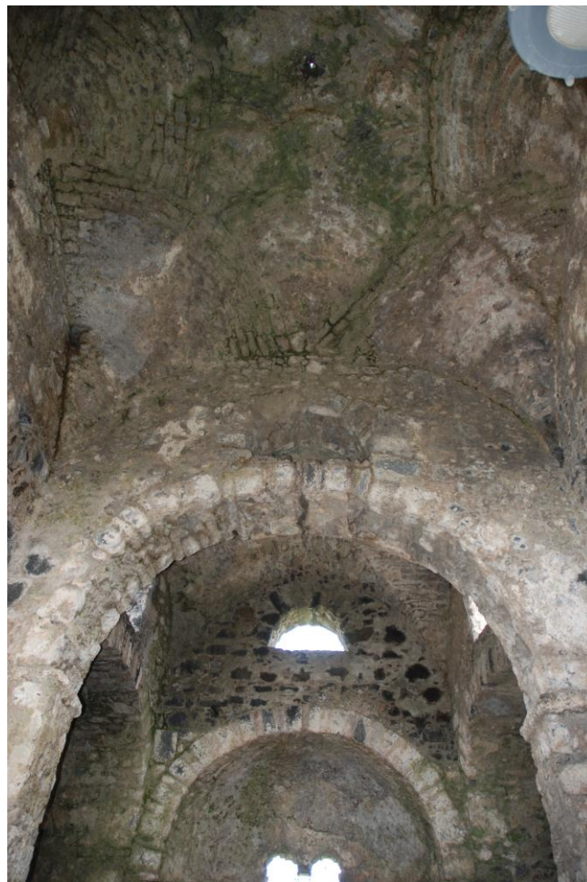
Cuba di Santa Domenica , sistema costruttivo delle cupole bizantine (visione dall'interno)
