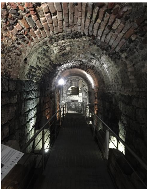
Corridoio d'ingresso con volta a botte
